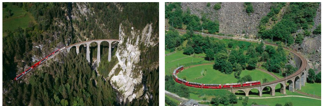
Abb. 22 Landwasserviadukt auf der Albulastrecke und Kreisviadukt Brusio auf der Berninastrecke
