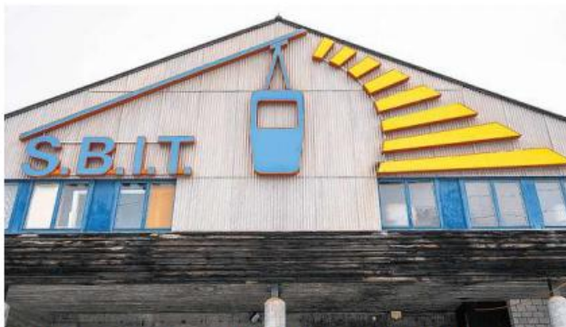
Ausser Betrieb: Die Anlagen der Bergbahnen San Bernardino stehen auch in diesem Winter still.
